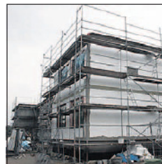
Das Gebäude ist eingerüstet. Ende des Jahres soll die Fassade fertig verputzt sein. So lange bleibt die Schule noch eine Baustelle.
